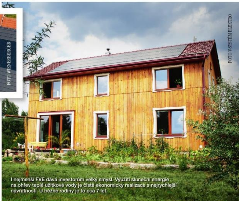
Fotovoltaické moduly Wevolt X-Tile, které se instalují přímo mezi střešní tašky, nabízí společnost Wienerberger. Moduly jsou kompatibilní se střešní krytinou Tondach.
