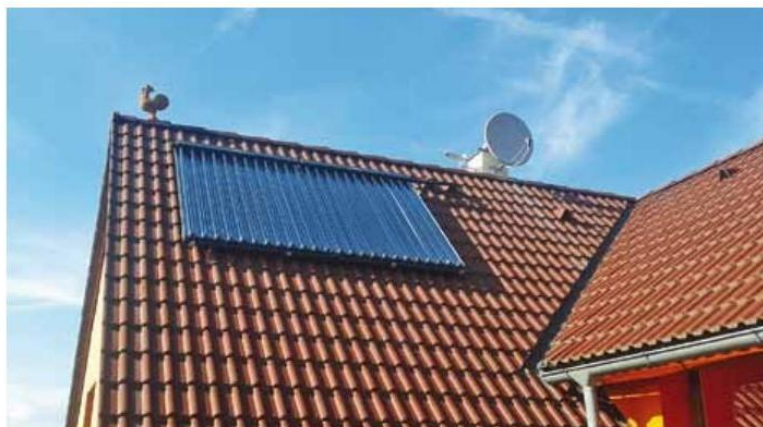
Pokud vám jde jen o ohřev vody, dobře poslouží termické solární kolektory. Vysokou účinnost nabízejí trubkové vakuové. Buderus
